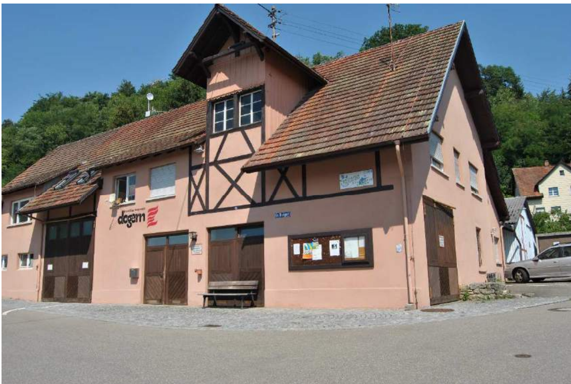
Bsp. Feuerwehrgerätehaus, Gebäudebestand mit energetischen, baulichen und funktionalen Mängeln
