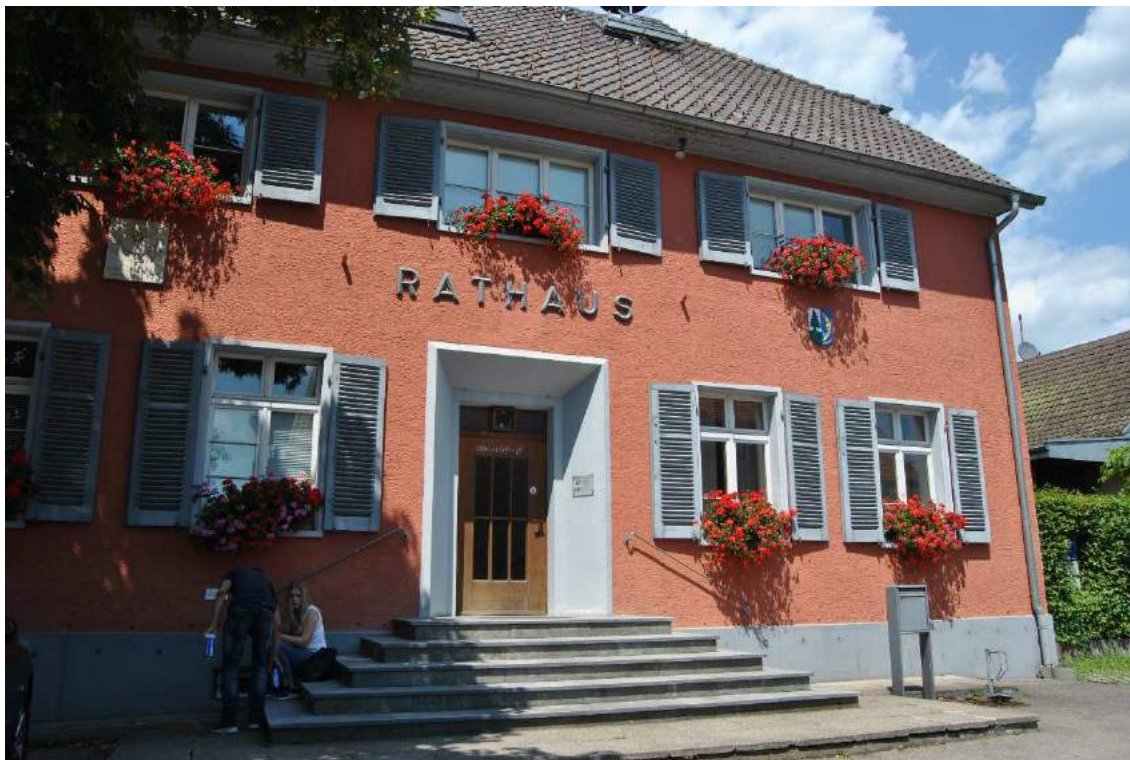
Bsp. Rathaus, Gebäudebestand mit energetischen, baulichen und funktionalen Mängeln
