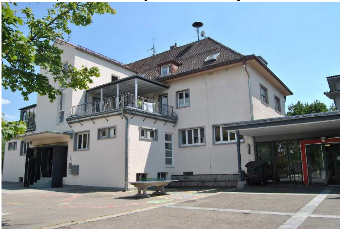
Bsp. Grundschule, Gebäudebestand mit energetischen und baulichen Mängeln
