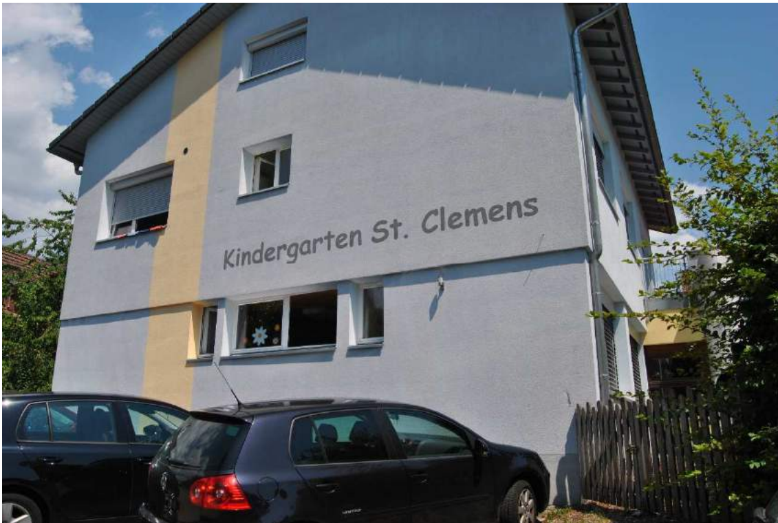
Bsp. Kindergarten St. Clemens, Gebäudebestand mit energetischen, baulichen und funktionalen Mängeln
