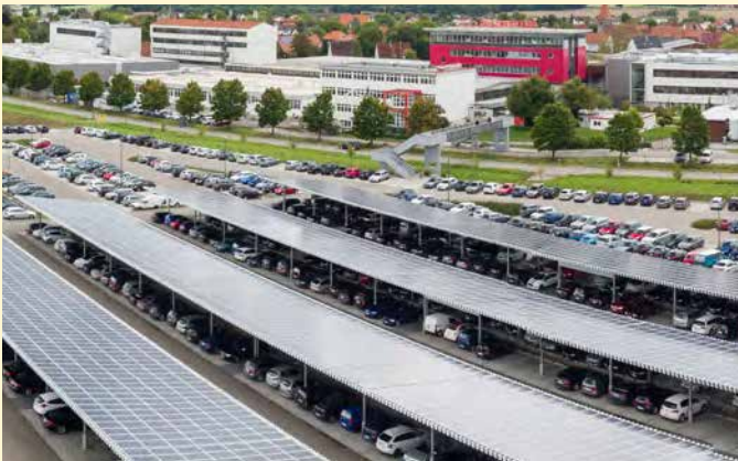
Photovoltaik-Parkplatz des Maschinenbauunternehmens Bausch+Ströbel in Ilshofen
